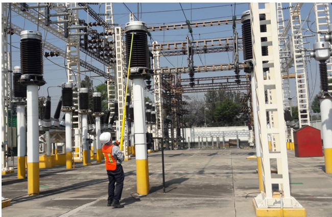
Test des isolateurs de traversée dans une sous-station
